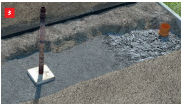
Afret betonen i den ønskede højde. (80-83 mm under tilstødende flise overkant). Kontrollér at fundament er i vatter eller med svagt fald mod udløb. Drænet skal lægges i den fugtige beton.
