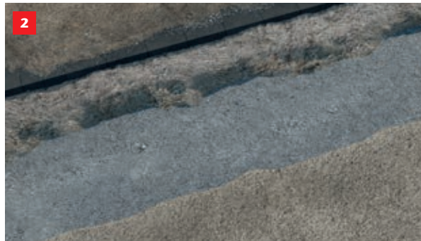
Betonklaplag/fundament udlægges.
