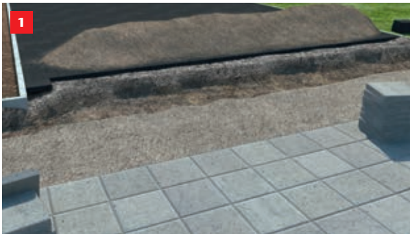
Fastlæg placering af linjedræn. Overvej placering af udløb. Grav en kanal – ca. 15 cm bred og 15-20 cm dyb.
